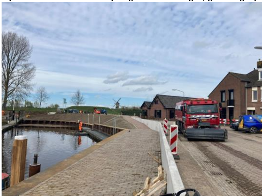
Figuur 5: Versterkingswerkzaamheden nabij de haven van Terheijden
