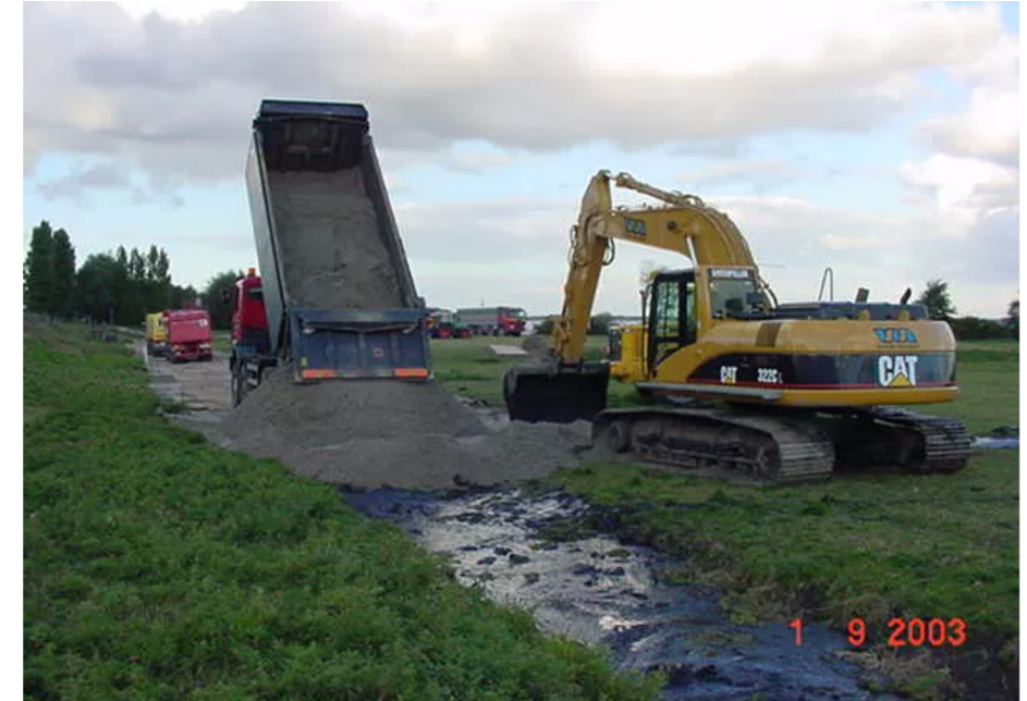
Dempen van een teensloot met zand (bron: Hoogheemraadschap van Delfland)
