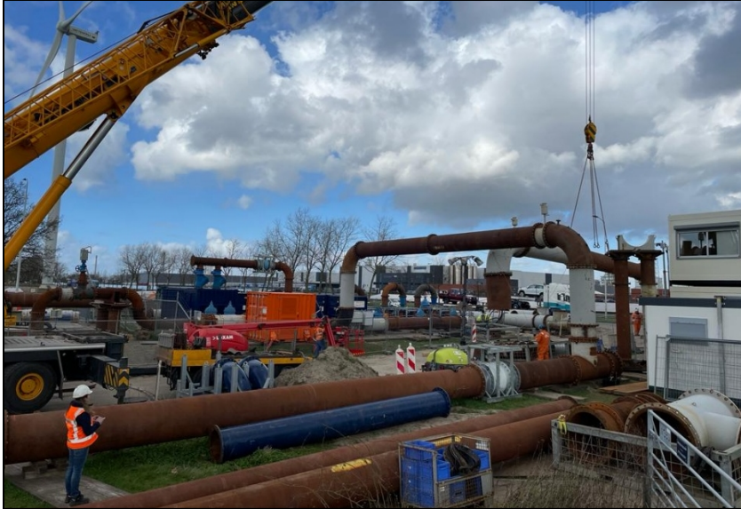
Met inzet van tijdelijke pompen en leidingen kon persstation Moerdijk worden omgebouwd
