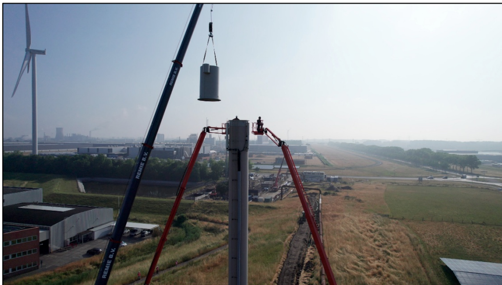
Om de capaciteit bij persstation Moerdijk te verhogen moet de druktoren worden verhoogd.
